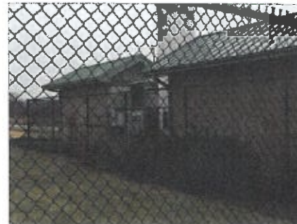
6 EXISTING SHELTER PHOTOS SCALE: N.T.S.
