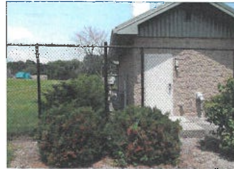
3 EXISTING SHELTER AND LANDSCAPING PHOTO SCALE: N.T.S.
