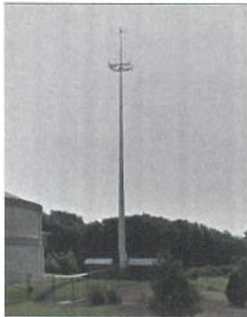
4 EXISTING SITE PHOTO SCALE: N.T.S.
