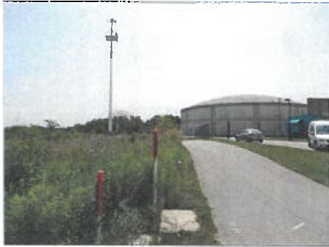
1 EXISTING TOWER PHOTO SCALE: N.T.S.
