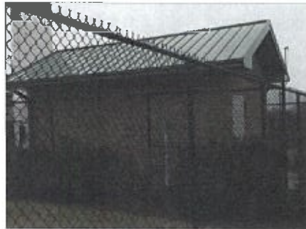
5 EXISTING SITE PHOTO SCALE: N.T.S.
