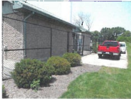
2 EXISTING SHELTER AND LANDSCAPING PHOTO SCALE: N.T.S.
